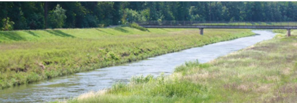
In schnurgeraden Fließgewässern, wie die Neue Luppe, fließt das Wasser sehr schnell, wodurch wenige Möglichkeiten des mikrobiellen Schadstoffabbaus bestehen.
