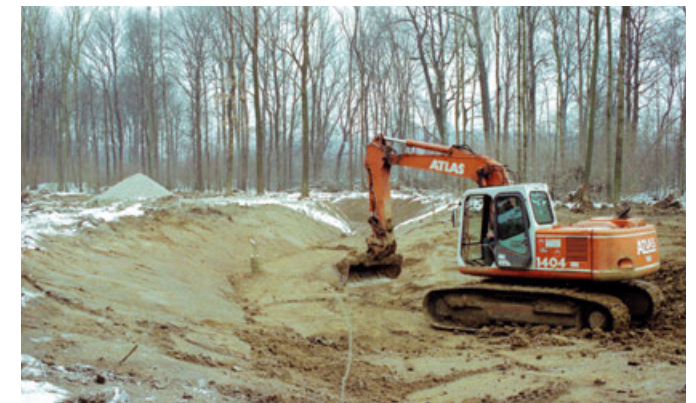
Der Burgauenbach wurde teils von Hand gegraben, teils kamen Bagger zum Einsatz.
